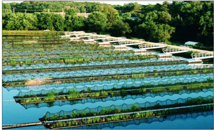
Baromfifeldolozó üzem 3800 m 3 /nap kapacitású Élőtavas szennyvíztisztítója
