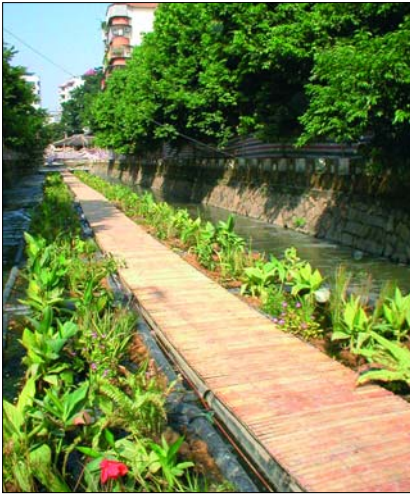
3000 m 3 /nap kapacitású, nyílt városi szennyvízfolyásra telepített szennyvíztisztító
